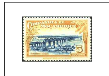
Pont sur le Zambèze
